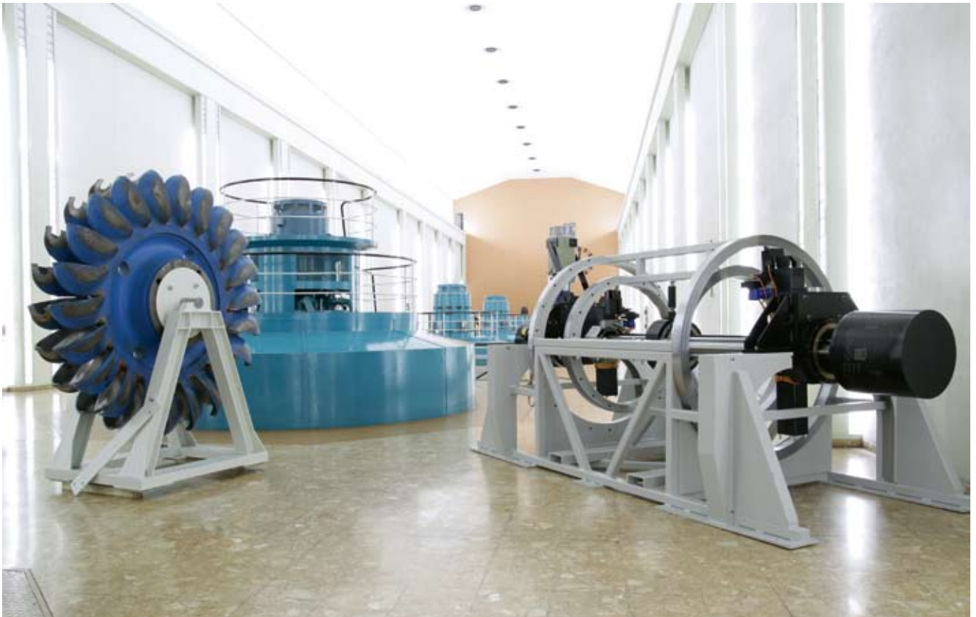
Bearbeitung von Turbinengehäusen direkt im Wasserkraftwerk
